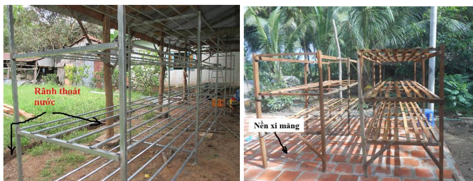
Hình 14. Nền nhà trồng có rãnh thoát nước (hình trái), nền xi măng (hình phải)
